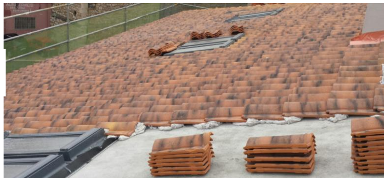
Tejado en construcción
