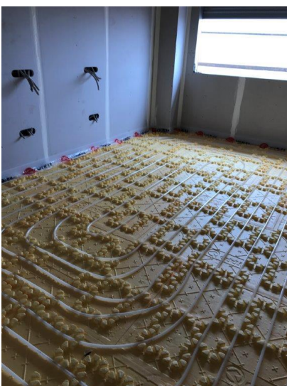
Montaje de suelo radiante en obra
